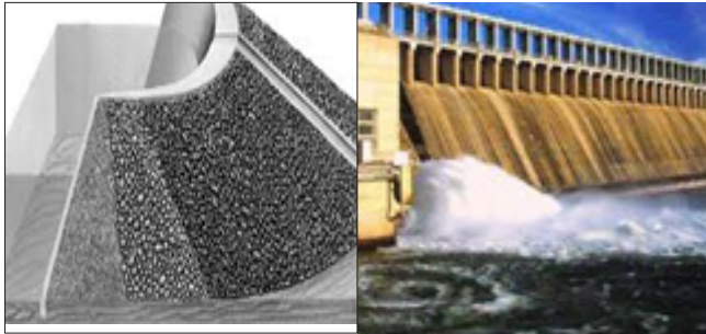
الشكل 7: تركيب السدود، حيث يزداد سمك جدار السد مع العمق مشابهة للعمود الفقري.
